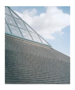
屋根機能(水密性、耐風強度、耐候性)と発電機能を合わせ持った屋根材一体型太陽電池を採用した実施例である。一般屋根材と太陽電池を載せた屋根材が同形状・同色でありデザイン性を損なうことなく設計されている。保護ガラスを使用していないため近隣への反射公害もない。
