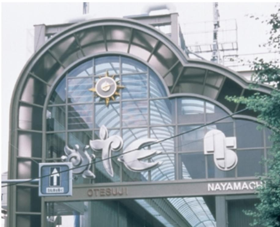
日本初の本格的なソーラーアーケード。屋根には単結晶、多結晶、アーケード出入口の上部にはシースルーアモルファス太陽電池が設置されている。
