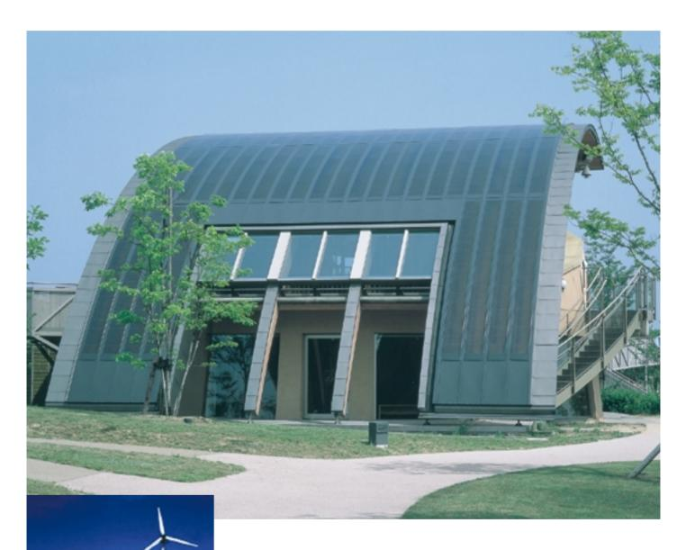
屋根材一体型の太陽電池パネルを採用し曲線屋根に応用したデザイン性の優れた建築物と風力発電設備を配置した設置例である。太陽光と風エネルギーは、常時系統連系されており自然エネルギーを上手に利用している。その仕組みや状態は、太陽電池の設置してある建物の中で楽しく学ぶ事ができるようになっている。
