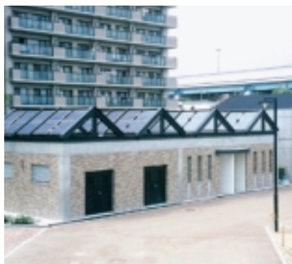
手洗・倉庫用の太陽電池
